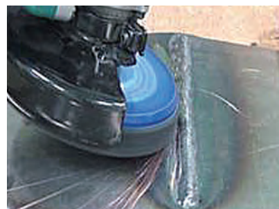
*odstraňovanie farebných defektov po zvaroch
